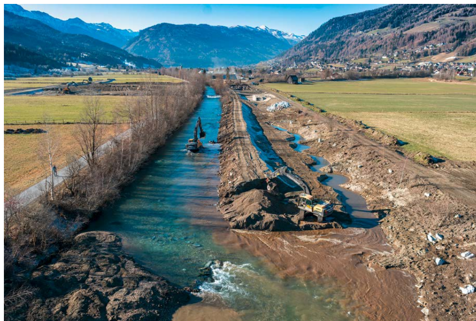
Bild auf Seite 25: beseitigte Begradigung, neuer aufgeweiteter pendelnder Verlauf der Mur (Blickrichtung flussabwärts)
