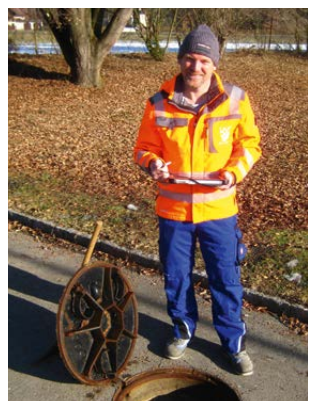
Wassermeister bei Schacht- bzw. Schachtdeckelwartung mit Wartungstool am Tablet
